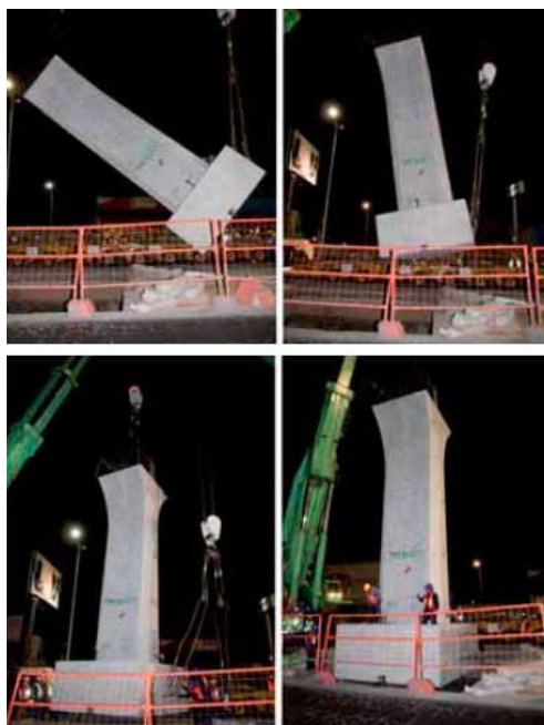
Proceso de instalación de elementos prefabricados.
