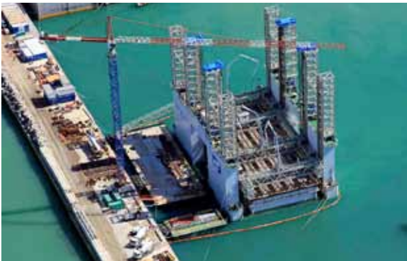
Estiba de cajones sobre barco semi sumergible para su traslado a Brasil.
